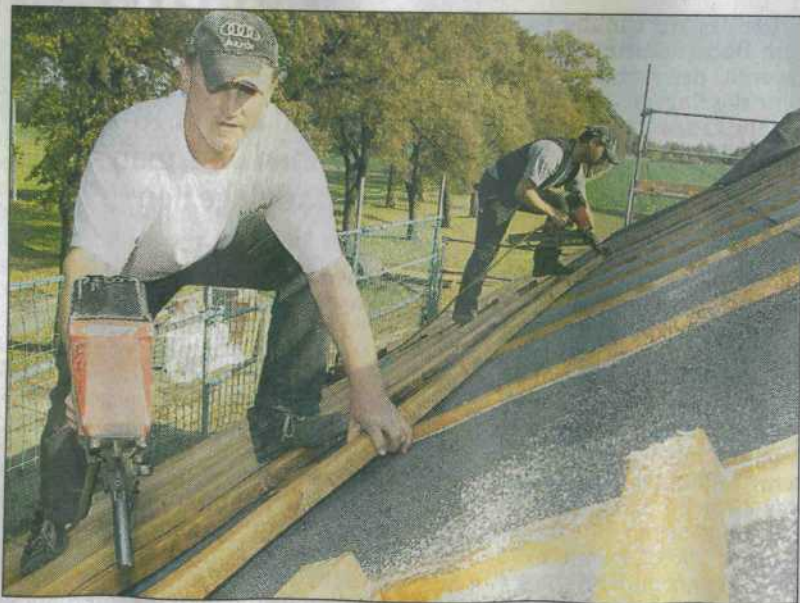
André Rohr und Ronny Spanke von der Steinaer Dachdeckerfirma Schneider Steina tackern die Dachlattung fest. Zum Glück hatte Petrus ein Einsehen mit dem Sportverein und unterstützte den Bau mit bestem Wetter. Foto: Schumann
